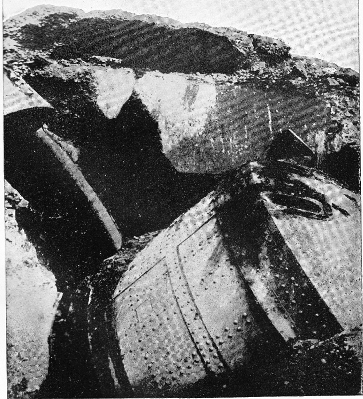
3.—LES FORTS DE LIÈGE : UNE COUPOLE DÉMOLIE.
